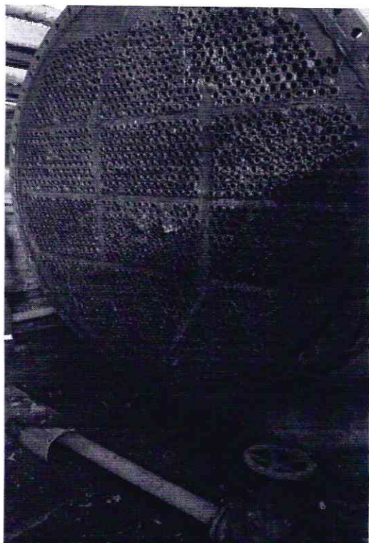
Фото 3 – трубное пространство испарителя поз.3/9 отд. Ж-7
